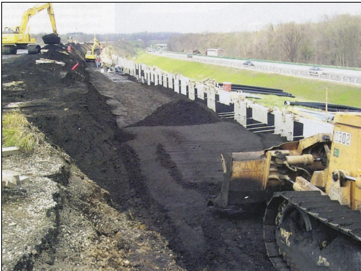
Ohio aprovou a areia de fundição para a aplicação geotécnica. A areia foi usada como base para uma terceira pista na rodovia expressa de Ohio
