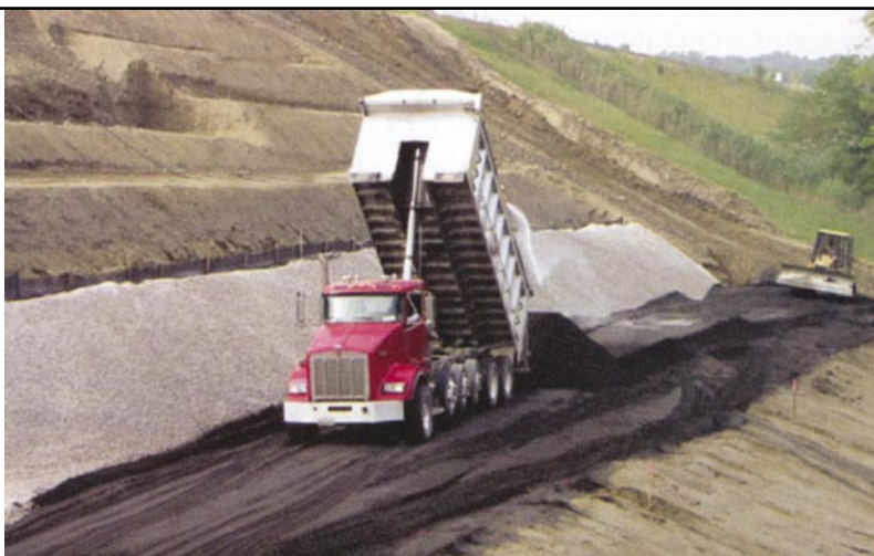
As aplicações geotécnicas incluem o uso de areia de fundição como a base para terraplenagem de estradas
